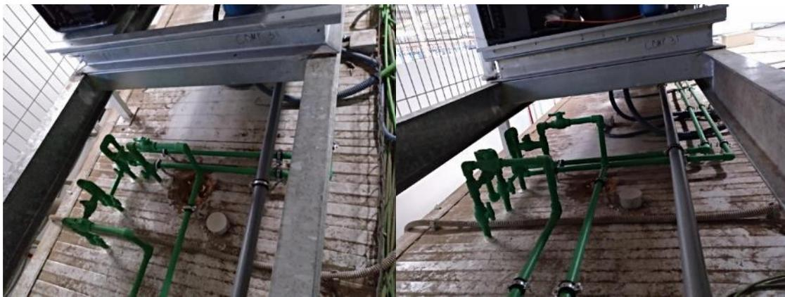
*Montaje tuberías con bypass en cubierta nave*
