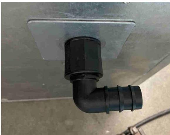
**ÉTAPE 8 :** Enfin, le bouchon étant maintenu en place avec la clé à ergot et le tuyau réduit étant maintenu en place avec la pince à bec de perroquet, nous pouvons maintenant serrer le kit pour qu'il n'y ait pas de fuite d'eau. Il sera vissé jusqu'au bout.
