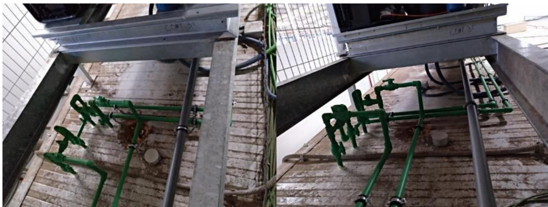
Montaggio tubi con bypass al coperto padiglione
