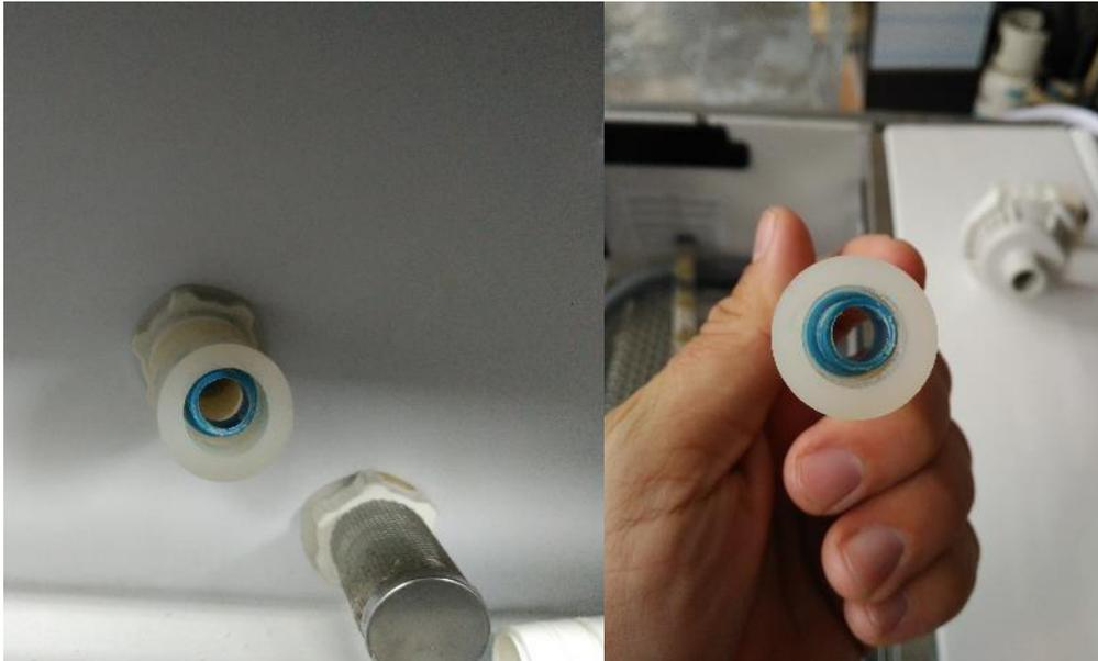
Limitatore blu all'interno del tubo che collega la pompa e il collettore
